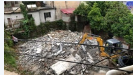
修建中的江口村卫生室
