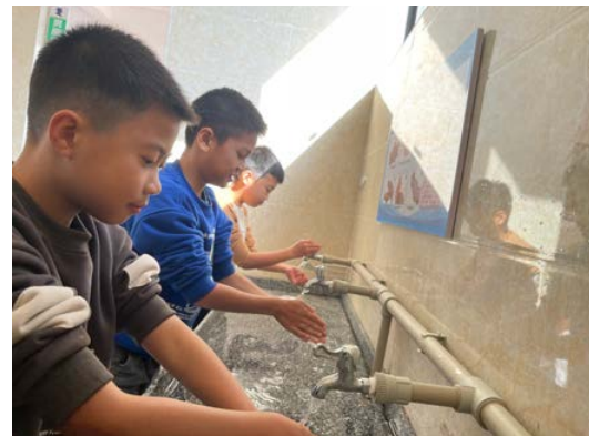
昭平县江口小学备用水源基础设施修复后
