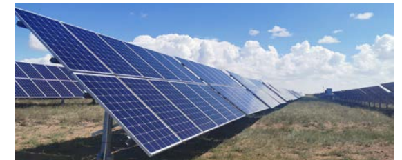
援建光伏村级电站
